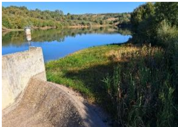
Figura 5. Barragem de Prada, setembro de 2025, Prada - Vinhais
